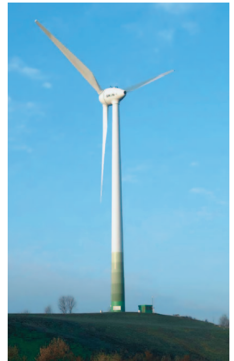
Windrad am Fröttmaninger Berg bei München mit 70m Nabenhöhe, 66m Rotordurchmesser, 1.500 Kilowatt (demgegenüber Lehmberg: 80m Nabe, 100m Rotor, 1.800 kW Quelle: wikimedia cc, Bbb auf wikivoyage shared
