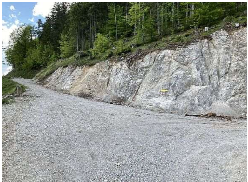
ÖBf-Forststraße Saalfelden, Foto: LUA
