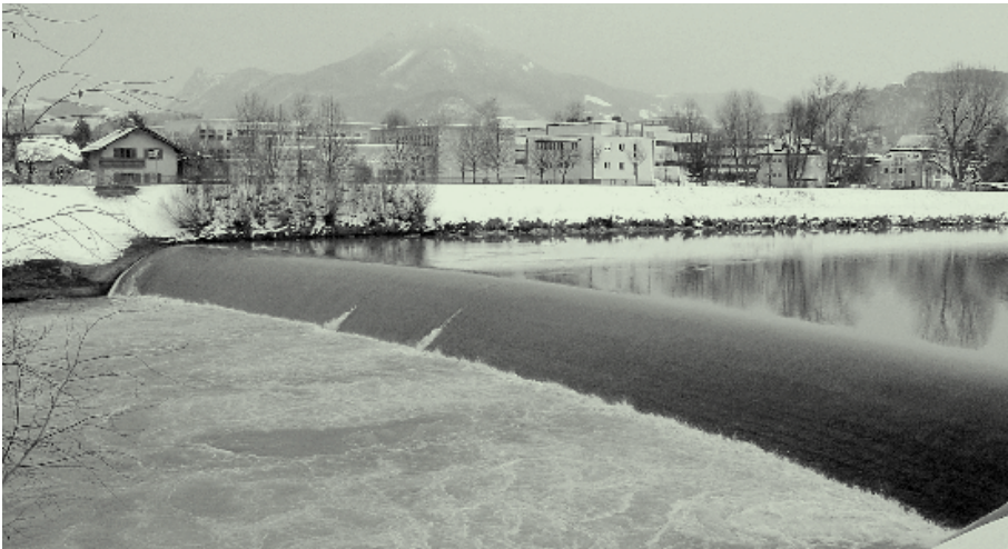
Die Sohlschwelle bei Hagenau
